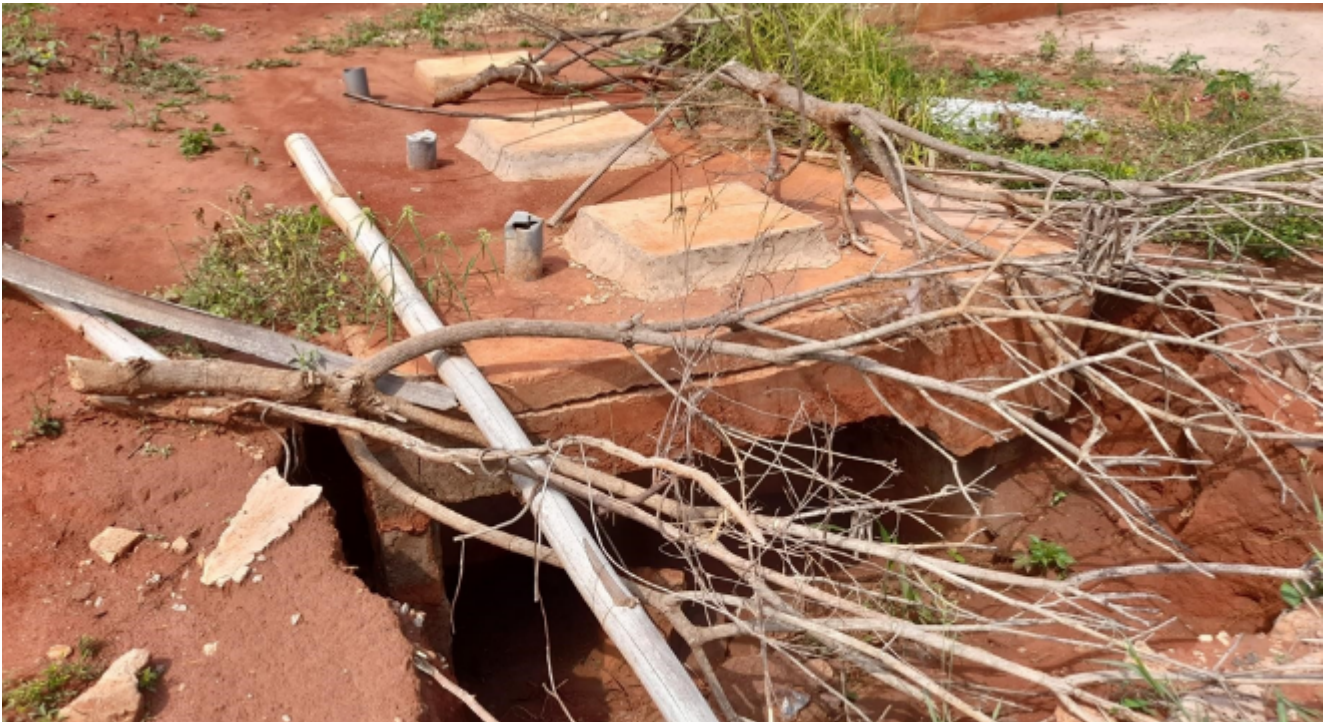
Collapsed manhole
